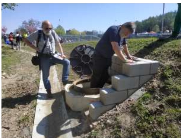
Foto č. 6 – PB PPO Sázava – Pohled na šachtu (uvnitř hradítka) prodloužení dešťové kanalizace SO 05.7.4.
