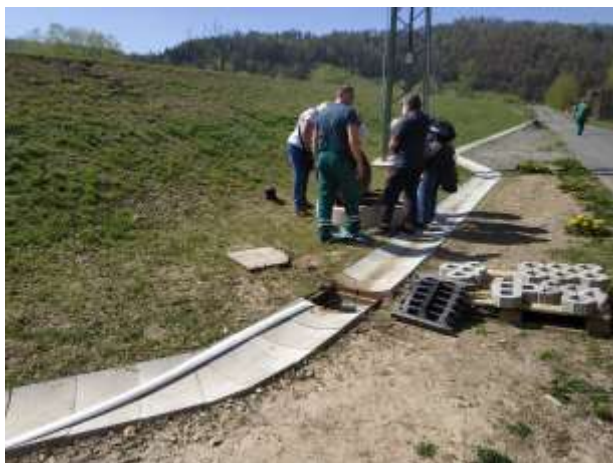
Foto č. 10 – PB PPO Sázava – Pohled na šachtu prodloužení dešťové kanalizace (uvnitř šachty hradítka a zpětná klapka) SO 05.7.1.
