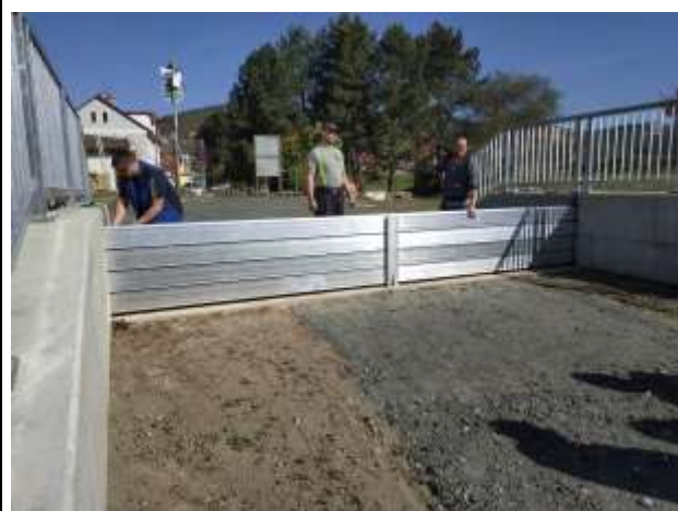
Foto č. 5 – PB PPO Sázava – Pohled na osazené mobilní hrazení v křížení OH s obslužnou komunikací PS 03.2
