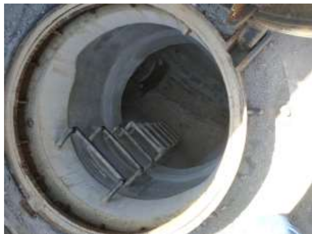
Foto č. 13 – PB PPO Sázava – Pohled do šachty přeložky odlehčovacího potrubí z ČS (uvnitř šachty hradítko) SO 05.1.2.
