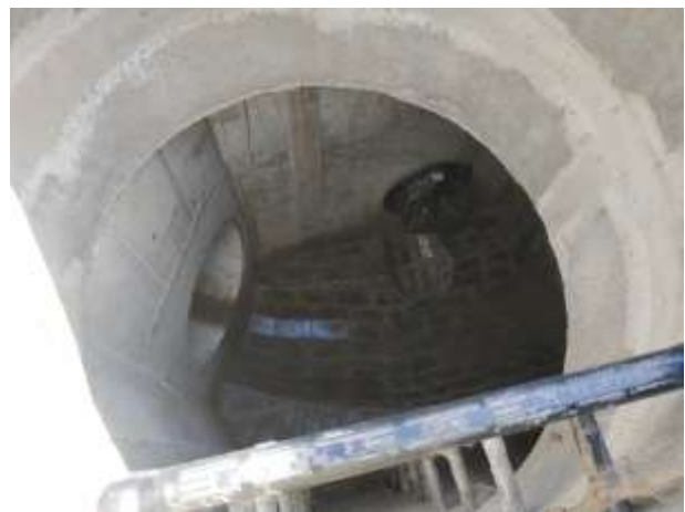
Foto č. 11 – PB PPO Sázava – Pohled do šachty prodloužení dešťové kanalizace (uvnitř šachty hradítka a zpětná klapka) SO 05.7.1.
