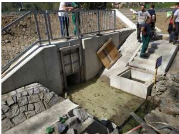
Foto č. 14 – PB PPO Sázava – Pohled na Propustek DN 800 SO 03.5.2 a čerpací stanici ČS II SO 03.5.2
