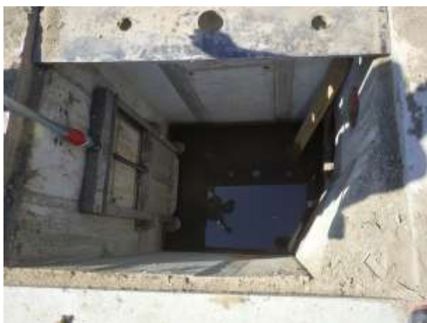
Foto č. 2 – PB PPO Sázava – Pohled do šachty SO 03.5.1 – Trubní propustek DN 500 se zaústěním dešťových kanalizací
