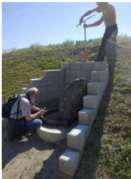
Foto č. 12 – PB PPO Sázava – Pohled na šachtu přeložky odlehčovacího potrubí z ČS (uvnitř šachty hradítka) SO 05.1.2.
